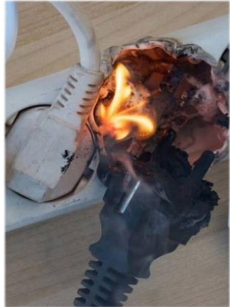
Bildquelle: MPS Elektrotechnik GmbH
